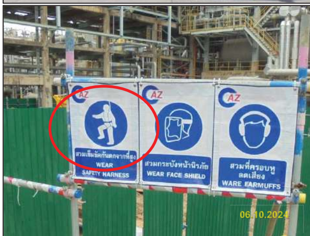
ง) การกั้นพื้นที่ด้านล่างและการติดตั้งป้ายเตือนการปฏิบัติงานบนที่สูง
