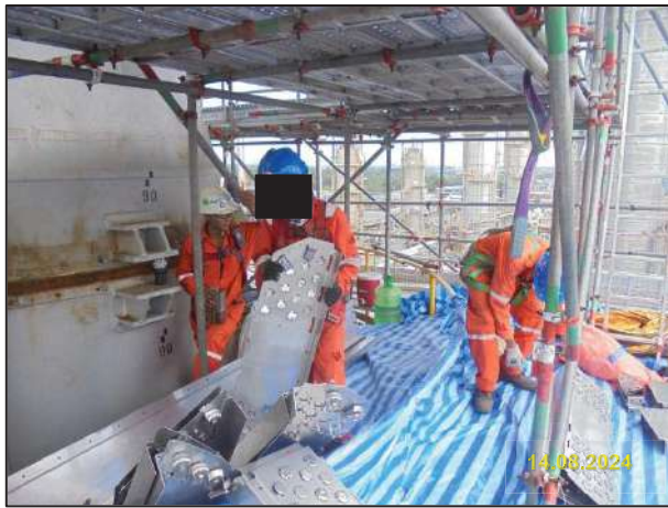
ผู้ช่วยเหลือ พร้อมด้วยอุปกรณ์ช่วยเหลือและอุปกรณ์ช่วยชีวิต บริเวณทางเข้า-ออกพื้นที่อับอากาศ
